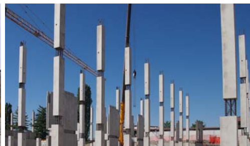
Pilastri Prefabbricati in Cls, a sez. rettangolare
