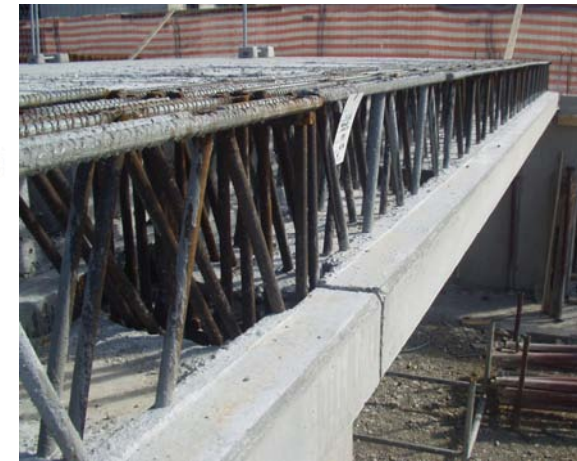
CON FONDELLO IN CLS
