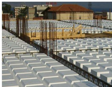
Solai in eps rinforzato
