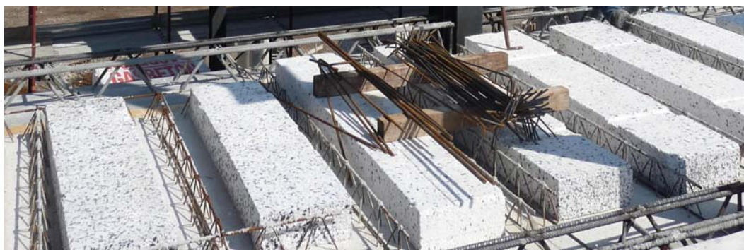
Solai a Lastre Tralicciate con Traliccio Normalizzato
