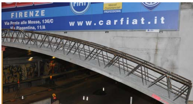
Solai a Lastre Tralicciate con Traliccio PREM
