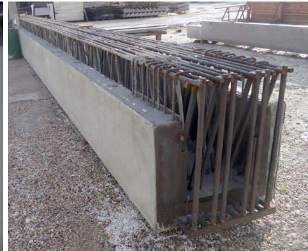
CON FONDELLO IN CLS
