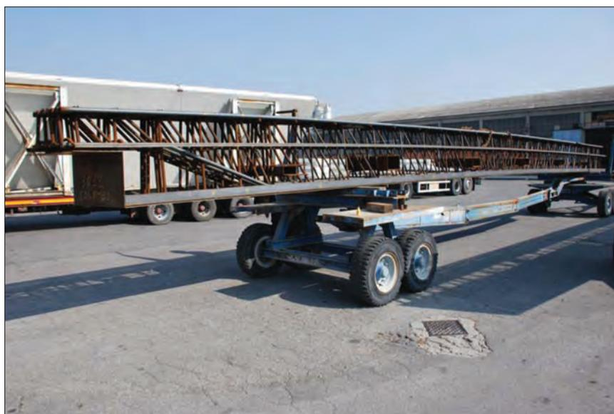
Figura 3 - Armatura di una trave reticolare mista
