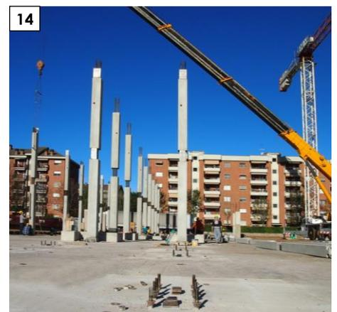
Fig. 8,9,10,11,12,13,14 – Immagini tipiche di pilastri Prefabbricati a Nodo Umido Strutturale
