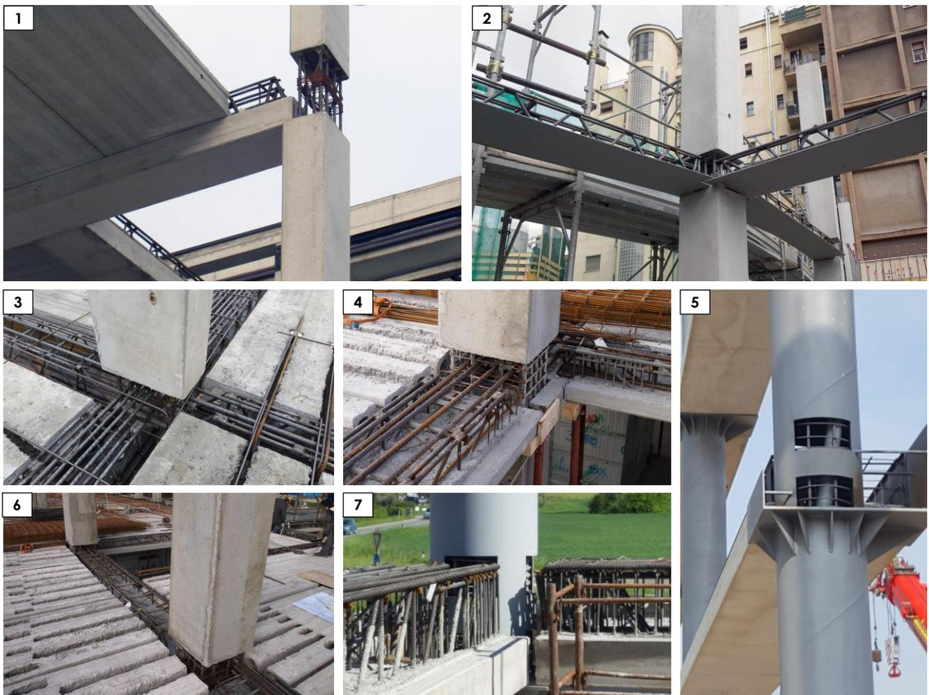
Fig. 1, 2, 3, 4, 5, 6, 7 – Nodo umido strutturale tipico del sistema costruttivo PREM
