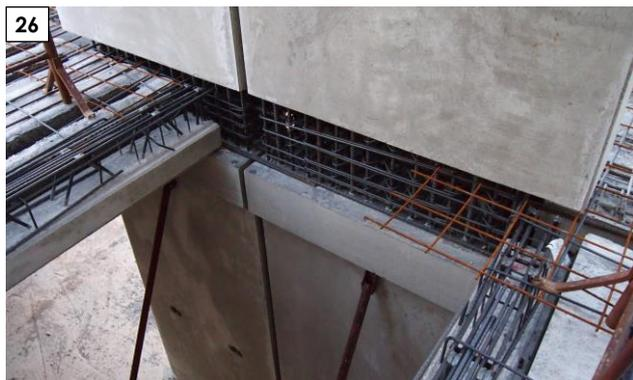
Questa soluzione fornisce una portata sufficiente solo per i carichi di prima fase, mentre i carichi di seconda fase saranno trasmessi direttamente al nucleo del pilastro tramite le armature integrative delle travi ed il calcestruzzo.
