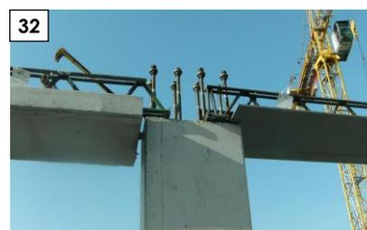
Fig. 30, 31, 32 – Travi PREM c.a. e miste acciaio cls su pilastri a NUS senza mensole
