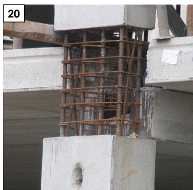
Per garantire un adeguato appoggio alle travi, nella fase di getto, si forma una gabbia di armatura dei pilastri più compatta che viene sovrapposta alla gabbia inferiore e superiore ed opportunamente dimensionata sia per tener conto della geometria ridotta che per tenere in conto il funzionamento in fase di montaggio.
