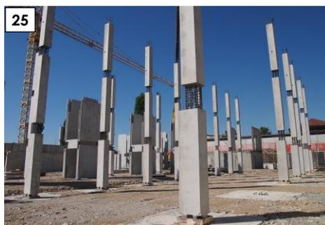
Fig. 20, 21, 22, 23, 24, 25 – appoggio travi su pilastri NUS senza mensole
