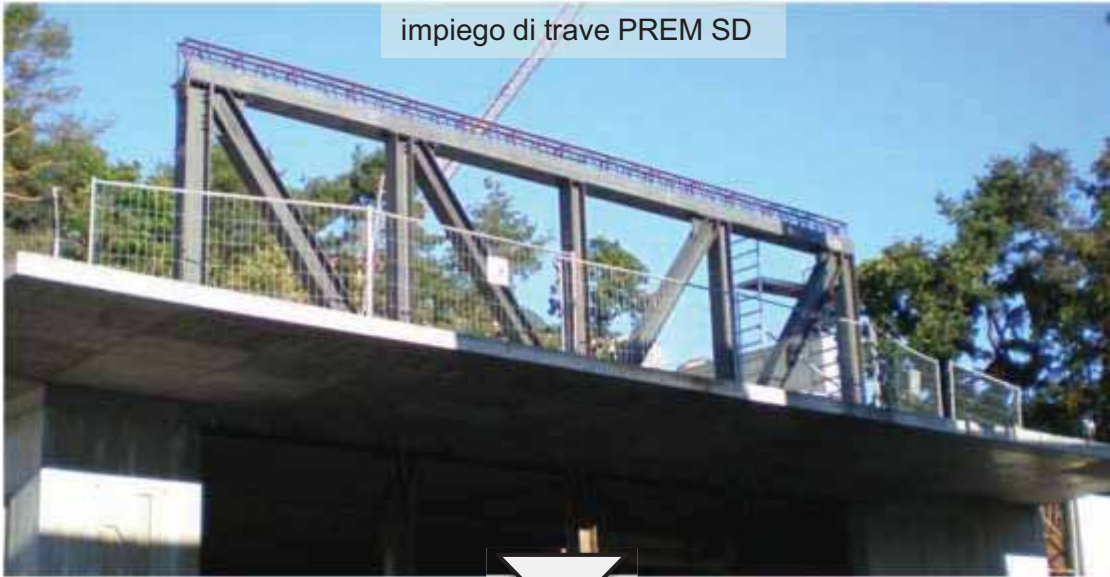
impiego di trave TLQ
