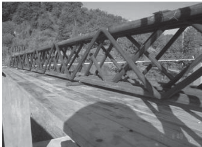
Figura 1 – Trave PREM con tralicci piani multipli.
