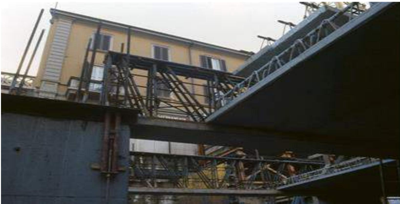
Quest'ultima nasce con l'obiettivo di avvicinare maggiormente il funzionamento a taglio delle travi tralicciate a quello delle travi in c.a. Infatti l'elemento verticale si concretizza, in seconda fase, in una staffa da c.a. e l'elemento obliquo si concretizza in una staffa da c.a. inclinata mentre il calcestruzzo si può schematizzare nelle bielle compresse realizzando, quindi, per intero il traliccio di Morsch.
