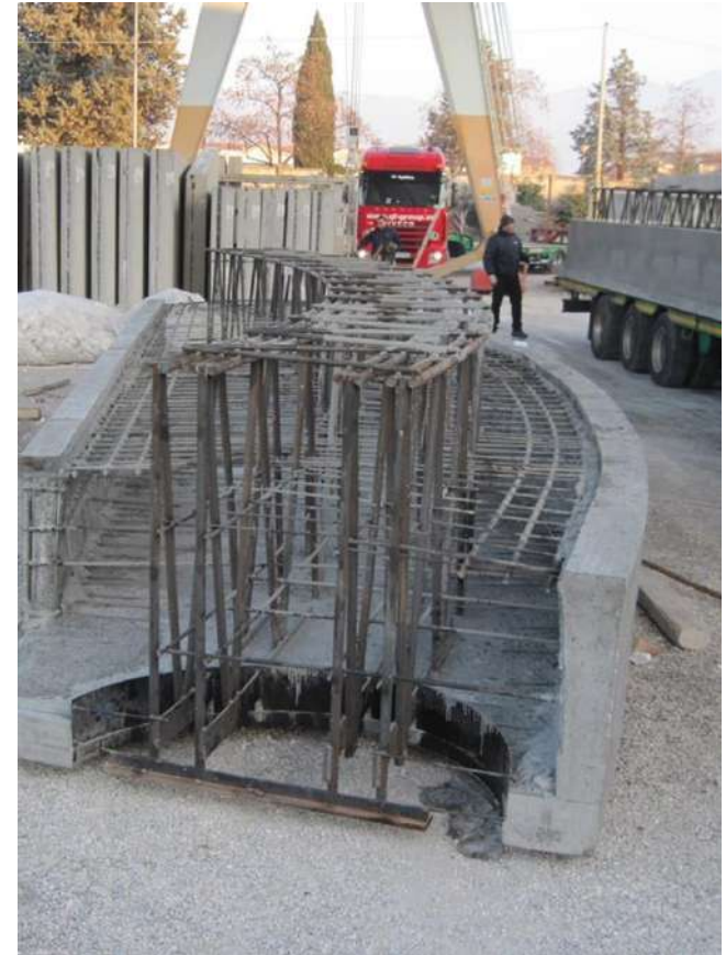
Nuovo molo marittimo (VE) – Travi PREM a2 con spandine in cls, sagomatura sul pilastro e con pianta curvilinea
