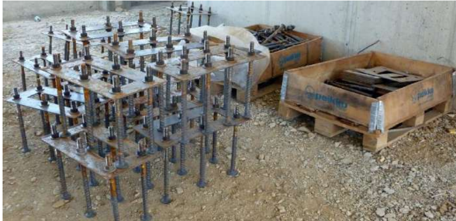
Gabbie di Tirafondi da inserire in fondazione
