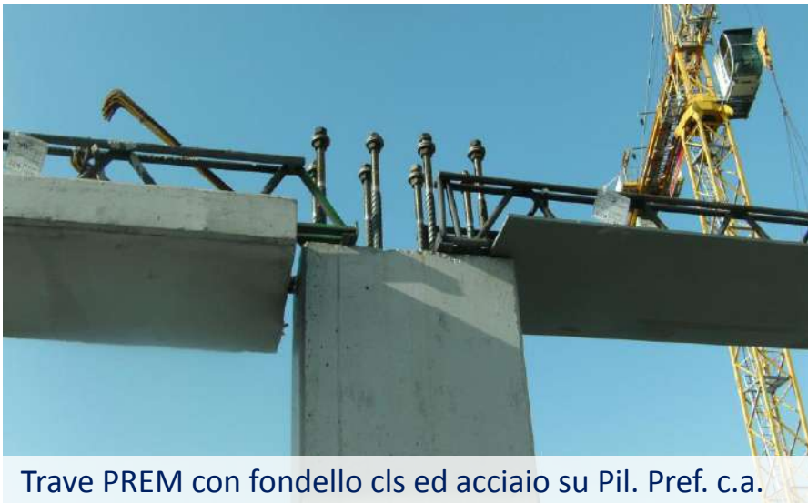
Pilastro con Mensola a spessore fondello Trave PREM
