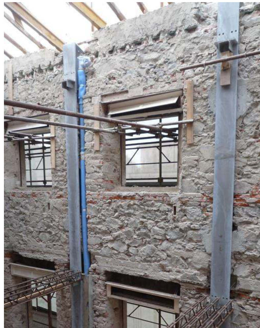
Ristrutturazione Stazione termale (PT) – Travi PREM a0 non autoportanti con solaio a travetti e pignatte
