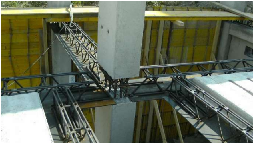
Travi PREM con fondello in acciaio su altre Travi PREM
