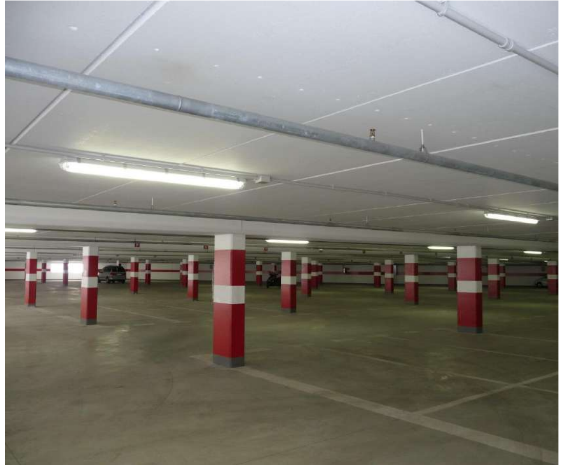
Nuovo parcheggio interrato (TN) – Travi PREM a2 su pilastri in opera
