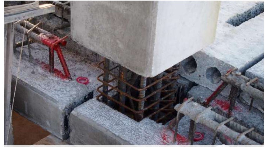
Particolare Trave PREM per confinamento cls del nodo
