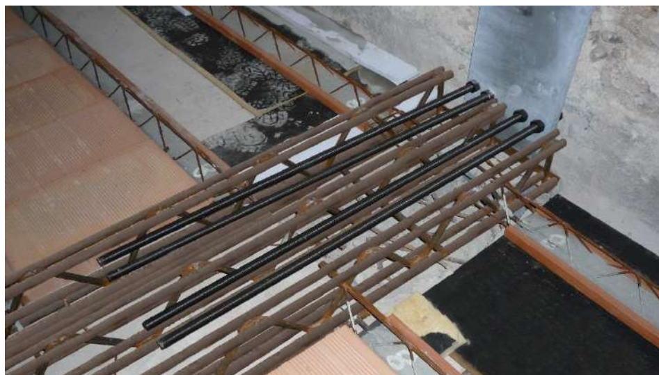
Ristrutturazione Stazione termale (PT) – Travi PREM a0 non autoportanti con solaio a travetti e pignatte
