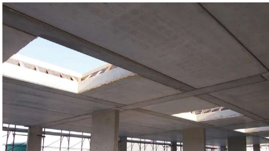
Uffici direzionali (VI): Travi PREM b2 – Solai a lastre nervate – Pilastri-Setti a Nodo Umido Strutturale
