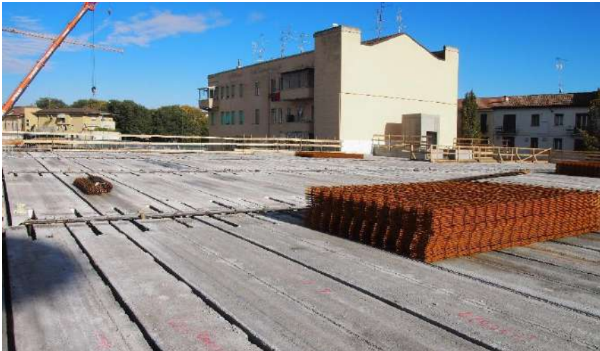
Parcheggio di un supermercato (AL) – Travi PREM b2 con Pilastri a N.U.S. a sezione biogivale
