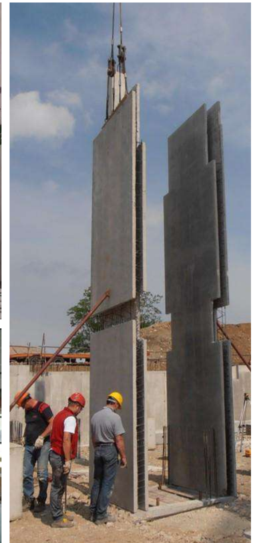
Hotel (TO) – Pilastri a N.U.S. con Travi PREM a2, Muri Doppia Lastra bipiano e una reticolare ad altezza di interpiano
