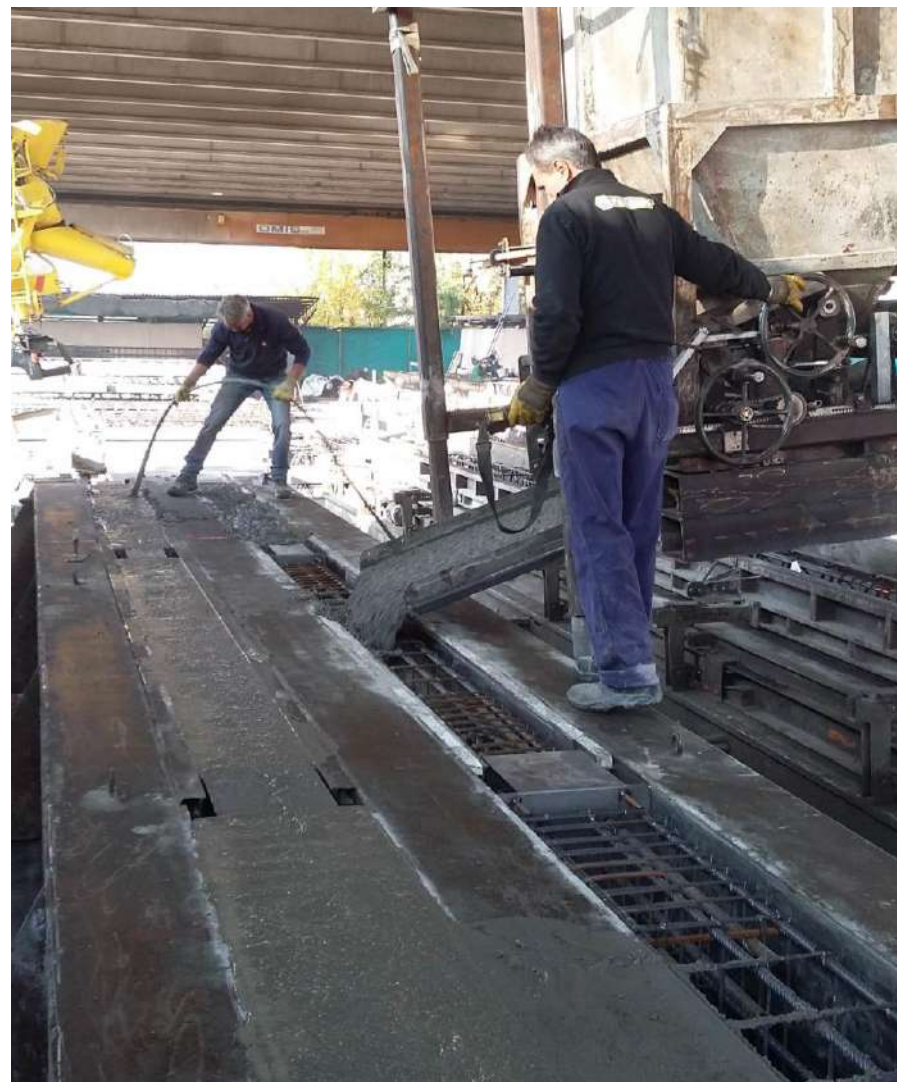
Getto di un Pilastro Prefabbricato a Nodo Umido Strutt.
