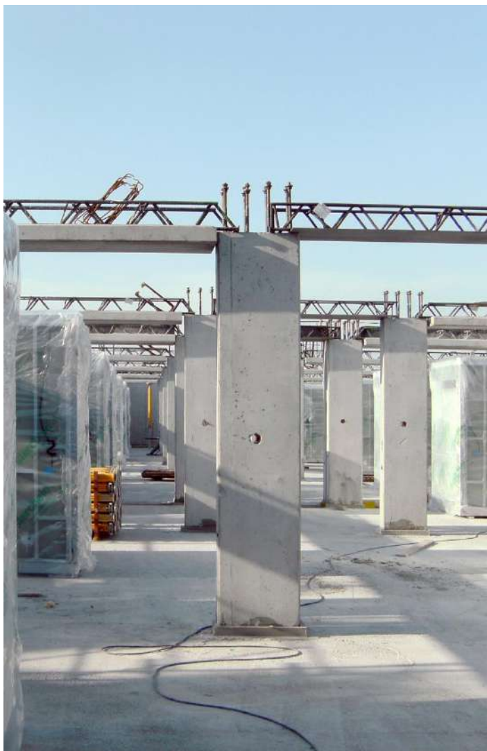
Nuova Residenza Universitaria (PD) – Travi PREM a2 (per stanze) ed a1 (per corridoio)
