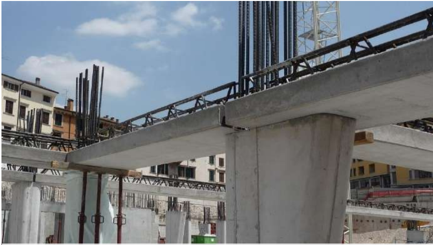
Travi PREM con fondello cls su pilastro c.a. gettato i.o.
