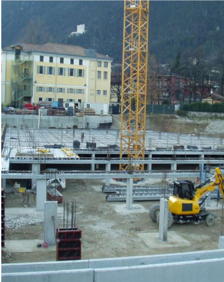
Nuovo parcheggio interrato (TN) – Travi PREM a2 su pilastri in opera
