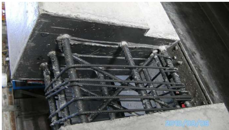
Mensola di piano con armatura rastremata e crociere
