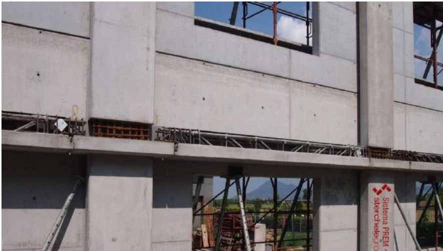
Mensole a spessore e pannello a contenimento getto
