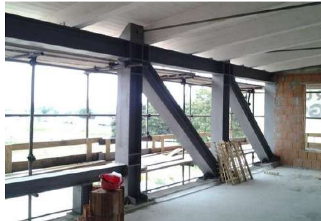
Hotel (TO) – Pilastri a N.U.S. con Travi PREM a2, Muri Doppia Lastra bipiano e una reticolare ad altezza di interpiano
