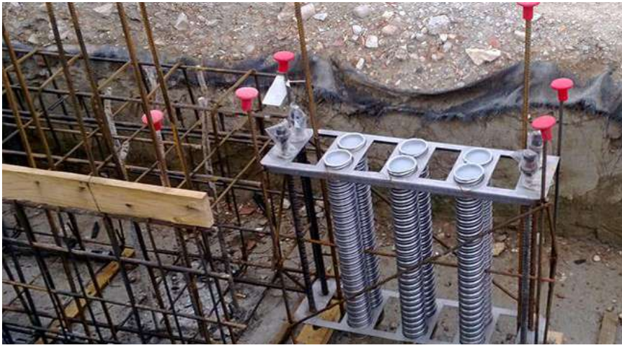
Gabbia di Tirafondi e Guaine Corrugate in fondazione
