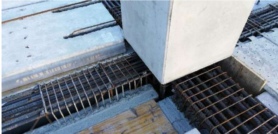
Travi PREM su Pilastro Prefabbricato c.a.
