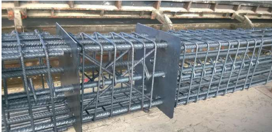
Mensola di Piano con rastremazioni d'armatura
