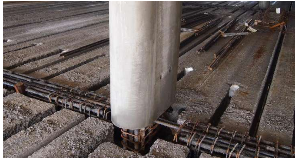
Parcheggio di un supermercato (AL) – Travi PREM b2 con Pilastri a N.U.S. a sezione biogivale
