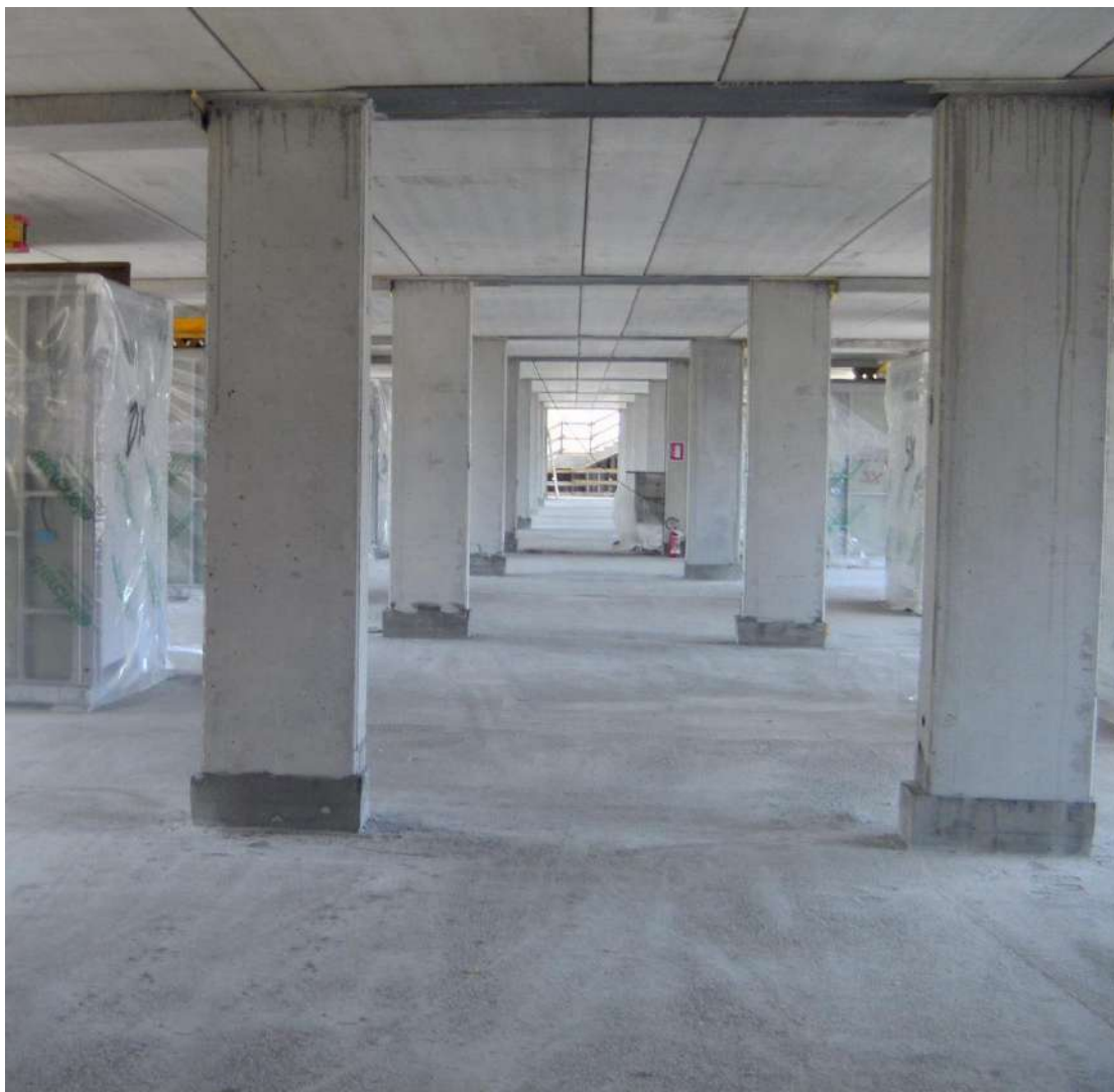
Nuova Residenza Universitaria (PD) – Travi PREM a2 (per stanze) ed a1 (per corridoio)
