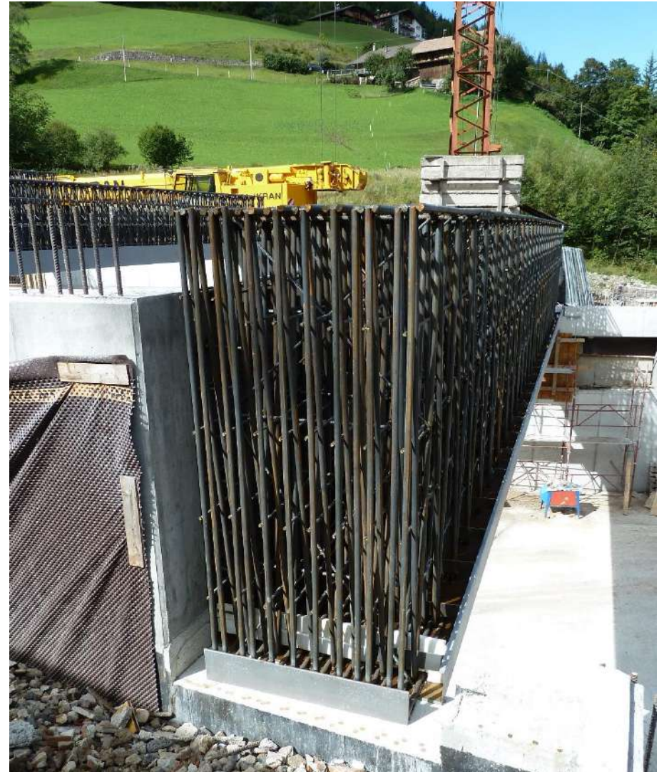
Nuovo parcheggio con copertura a gradoni (BZ) – Travi PREM a1 con casseri in lamierino a perdere
