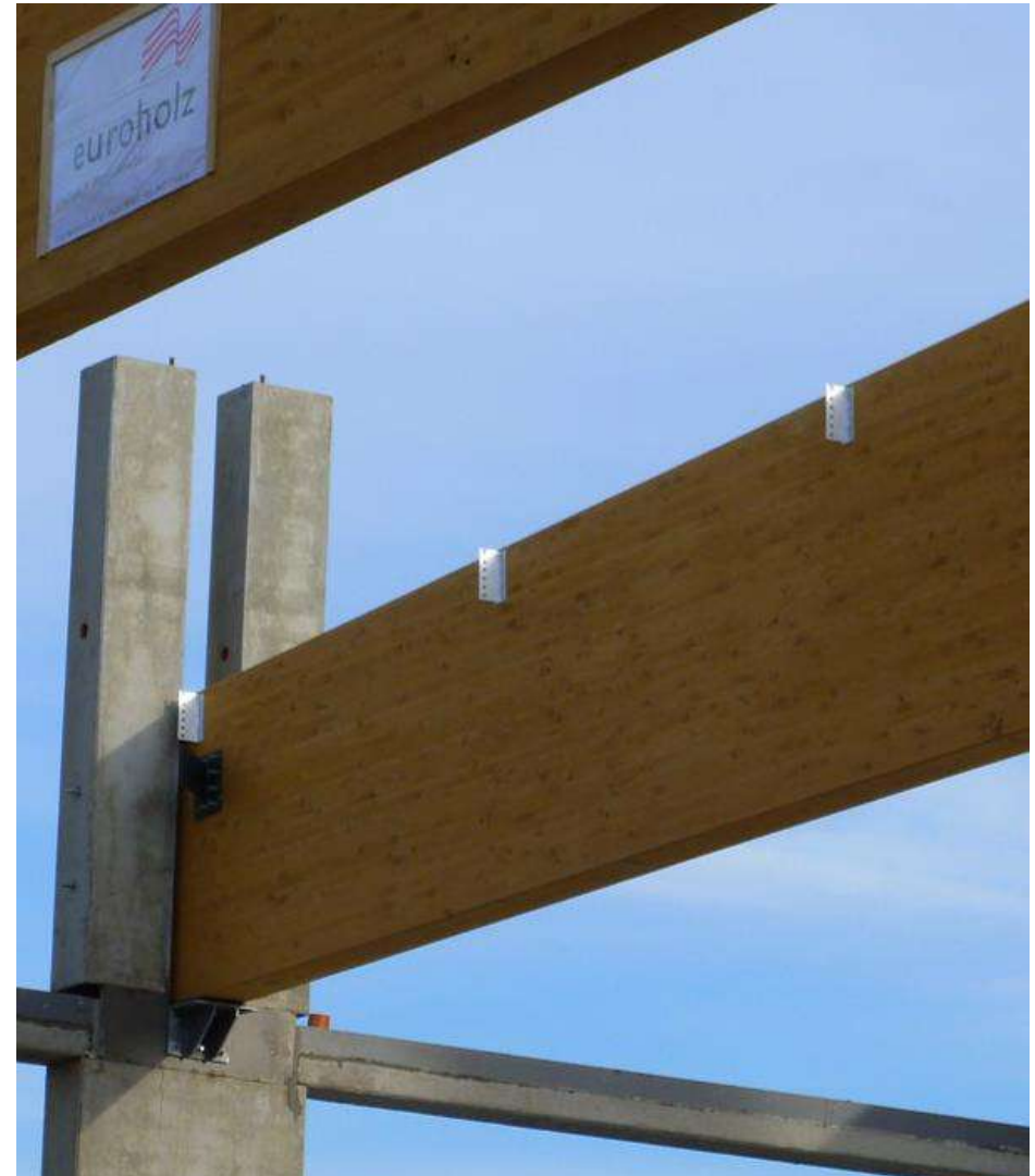
Palazzetto dello sport (VI) –Travi PREM a2 e Pilastri a N.U.S. in una direzione; nodo a secco in direzione 2
