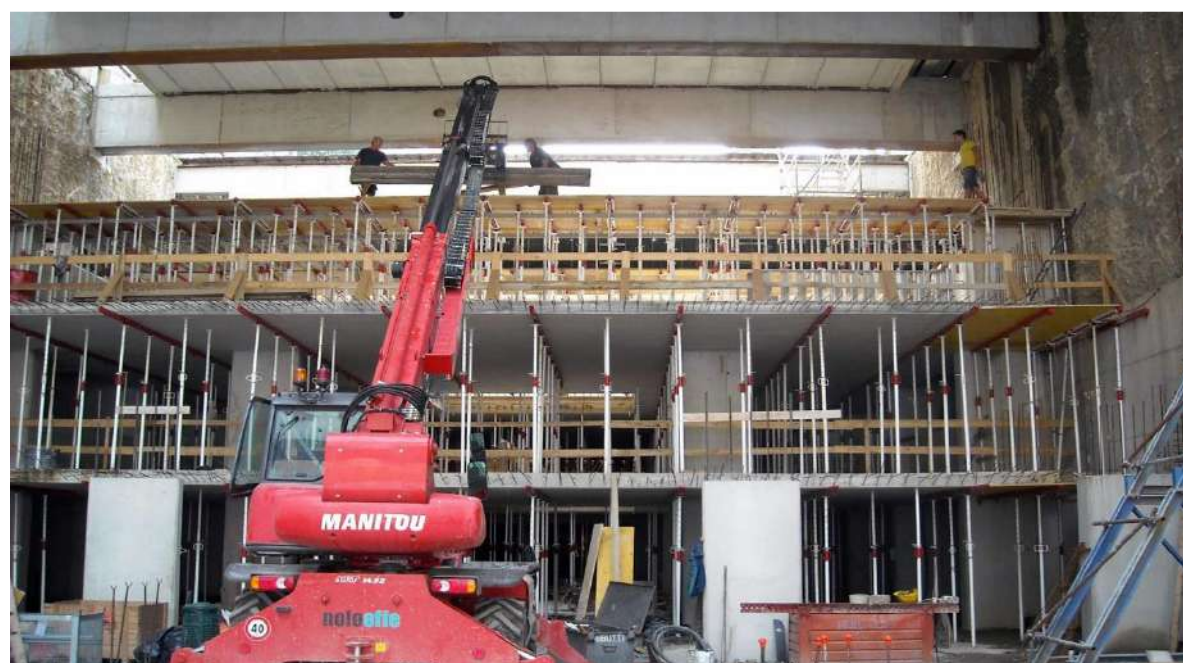
Parcheggio Interrato Top Down (MI) – Travi PREM a1
