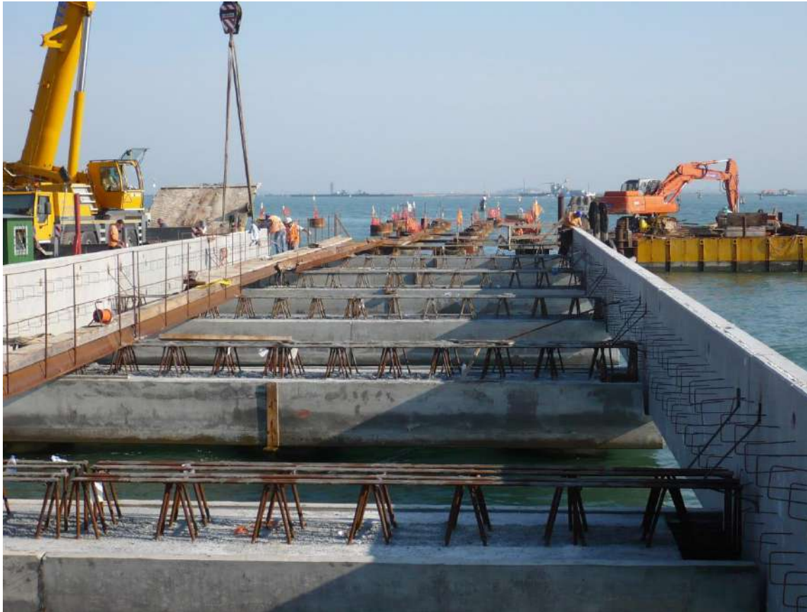
Nuovo molo marittimo (VE) – Travi PREM a2 con spandine in cls, sagomatura sul pilastro e con pianta curvilinea
