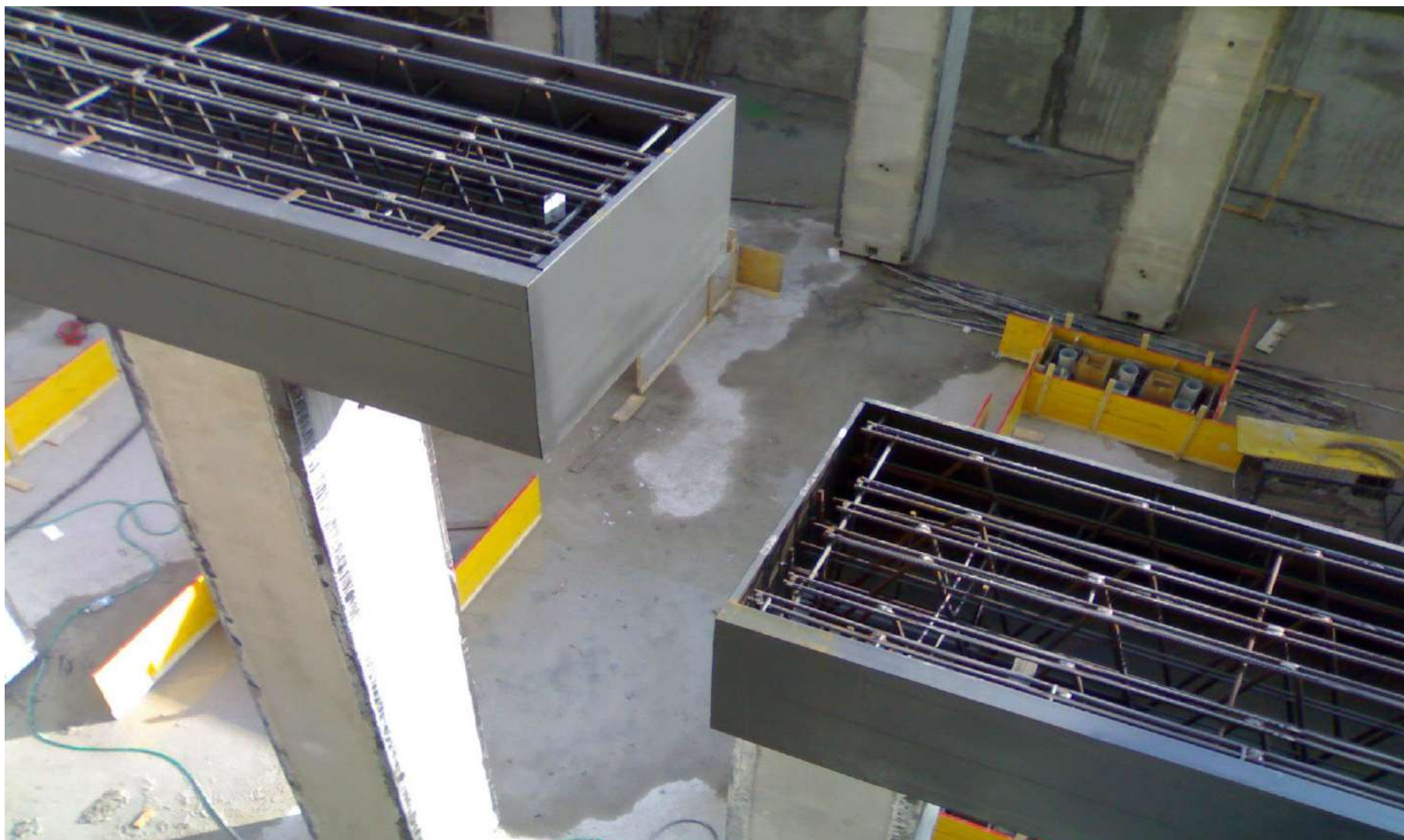
Ampliamento acciaieria (VE) –Travi PREM a0 autoportanti, con spondine e fondello in lamierino, su pilastro in c.a.
