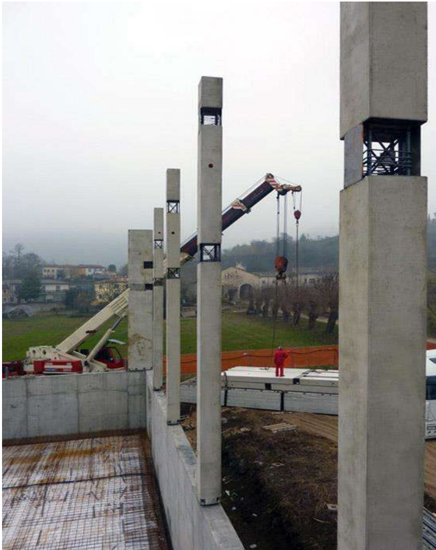
Palazzetto dello sport (VI) –Travi PREM a2 e Pilastri a N.U.S. in una direzione; nodo a secco in direzione 2
