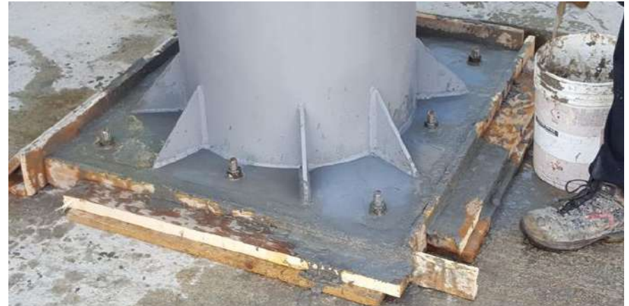
Posa e inghisaggio di un Pilastro Cerchiato Misto
