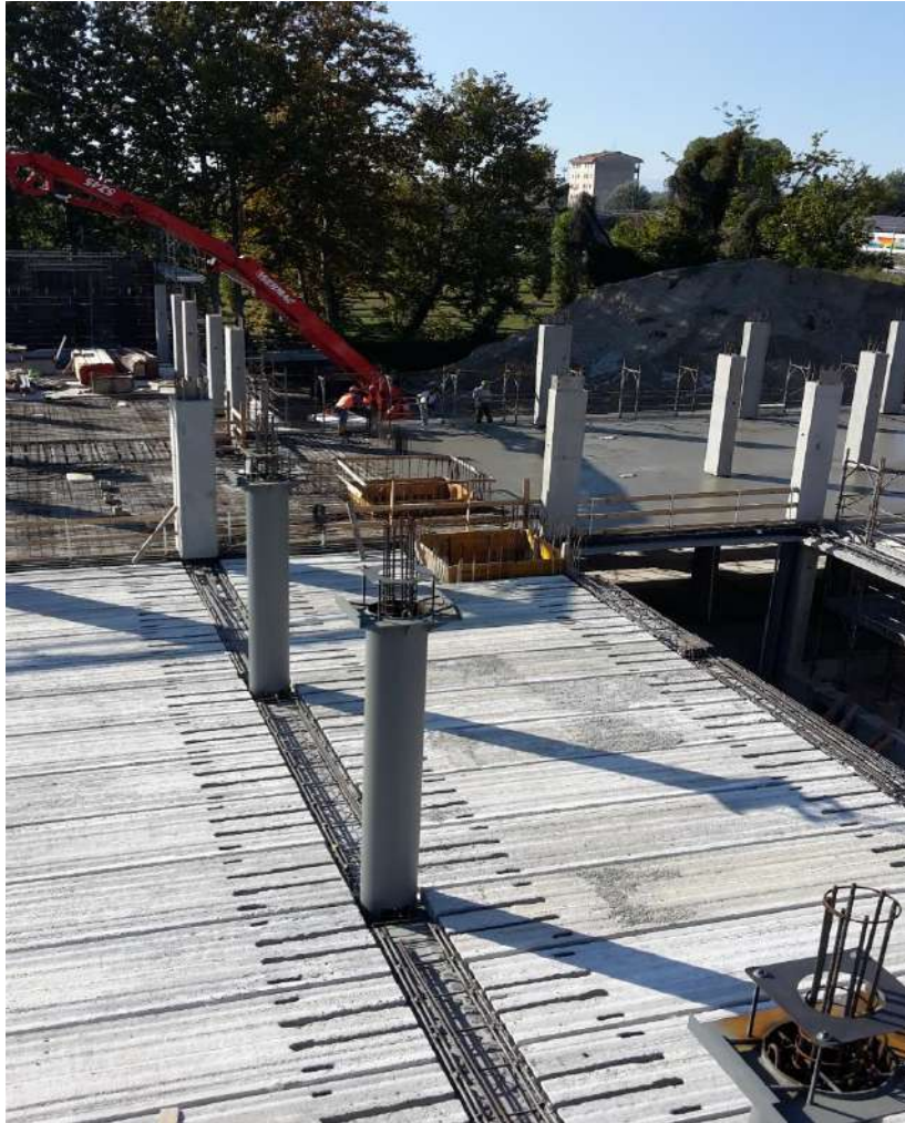
Nuova RSA(MI) – Travi PREM b2 su pilastrini a N.U.S. e Pilastrini Tubolari in acciaio cat. Cls armato
