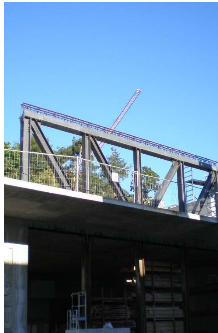
Uffici direzionali (BZ) – Travi PREM a1 con tiranti e puntoni per una reticolare ad altezza di interpiano
