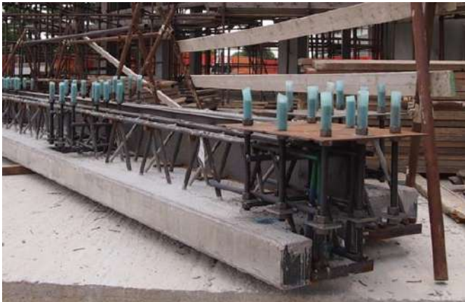
Hotel (TO) – Pilastri a N.U.S. con Travi PREM a2, Muri Doppia Lastra bipiano e una reticolare ad altezza di interpiano
