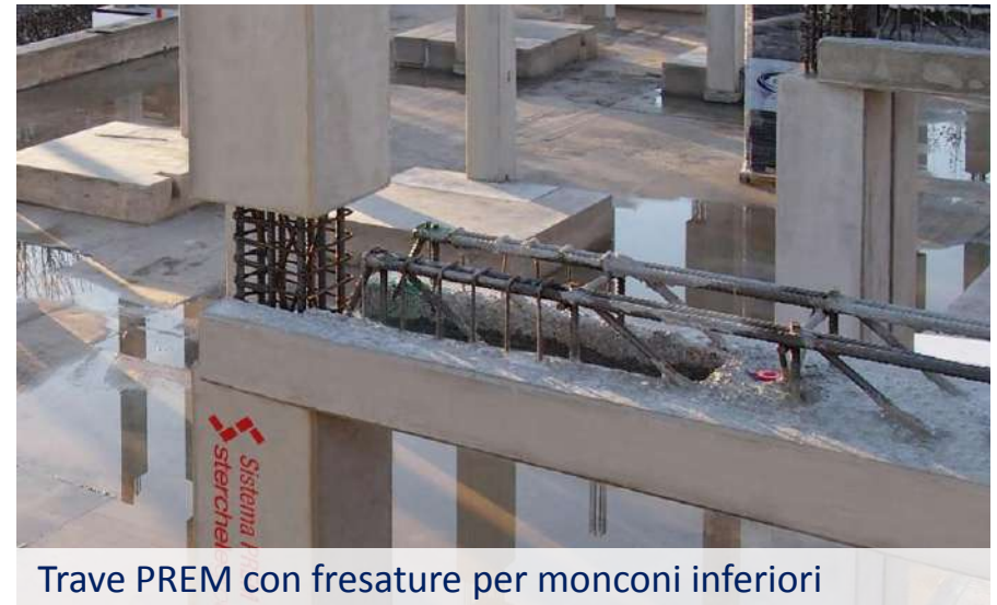
Nodo U.S. anche fra Travi PREM e Solaio (Alveolare)
