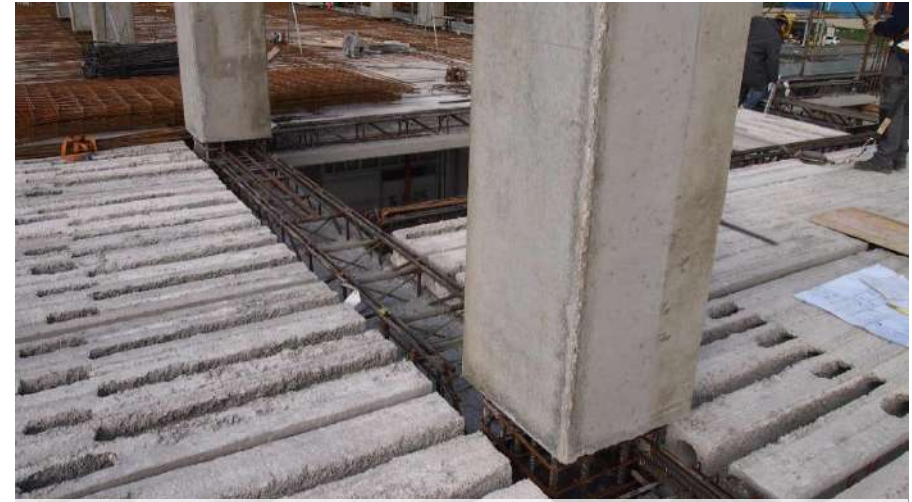
Nodo U.S. anche fra Travi PREM e Solaio (Alveolare)
