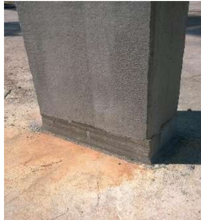
Posa e inghisaggio di un Pilastro Prefabbricato a N.U.S.
