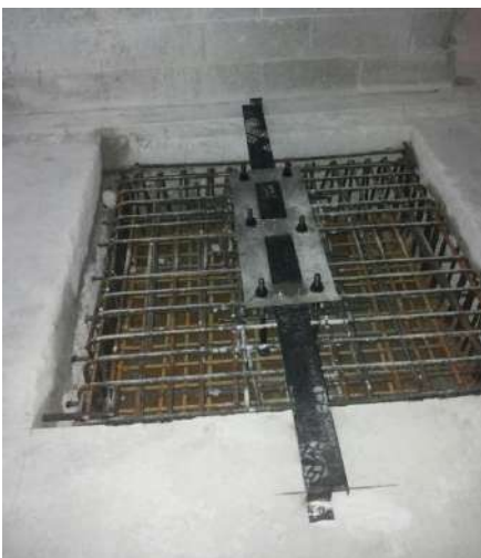
Condominio (Roma) – Pilastri a N.U.S. con Travi PREM b2+alveolare al primo piano e a1+solaio a tralici per gli altri
