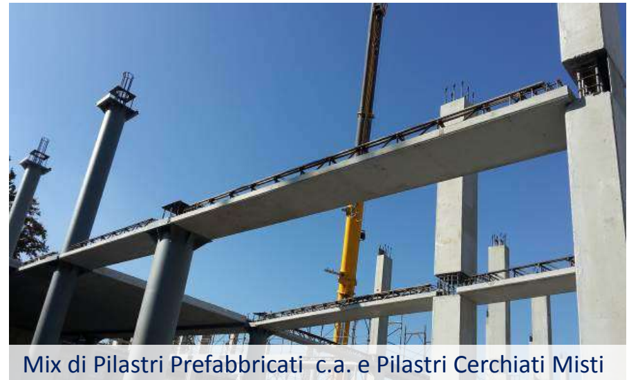
Particolare Trave PREM per confinamento cls del nodo
