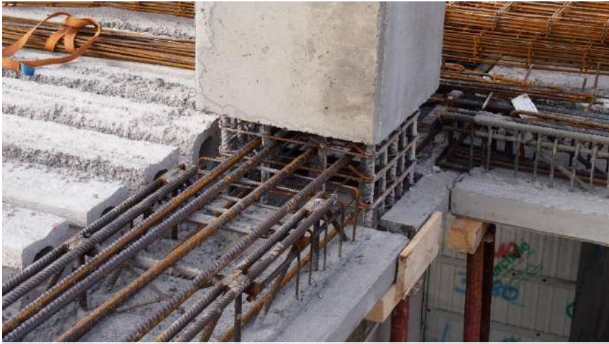
Pilastro con Mensola a spessore fondello Trave PREM
