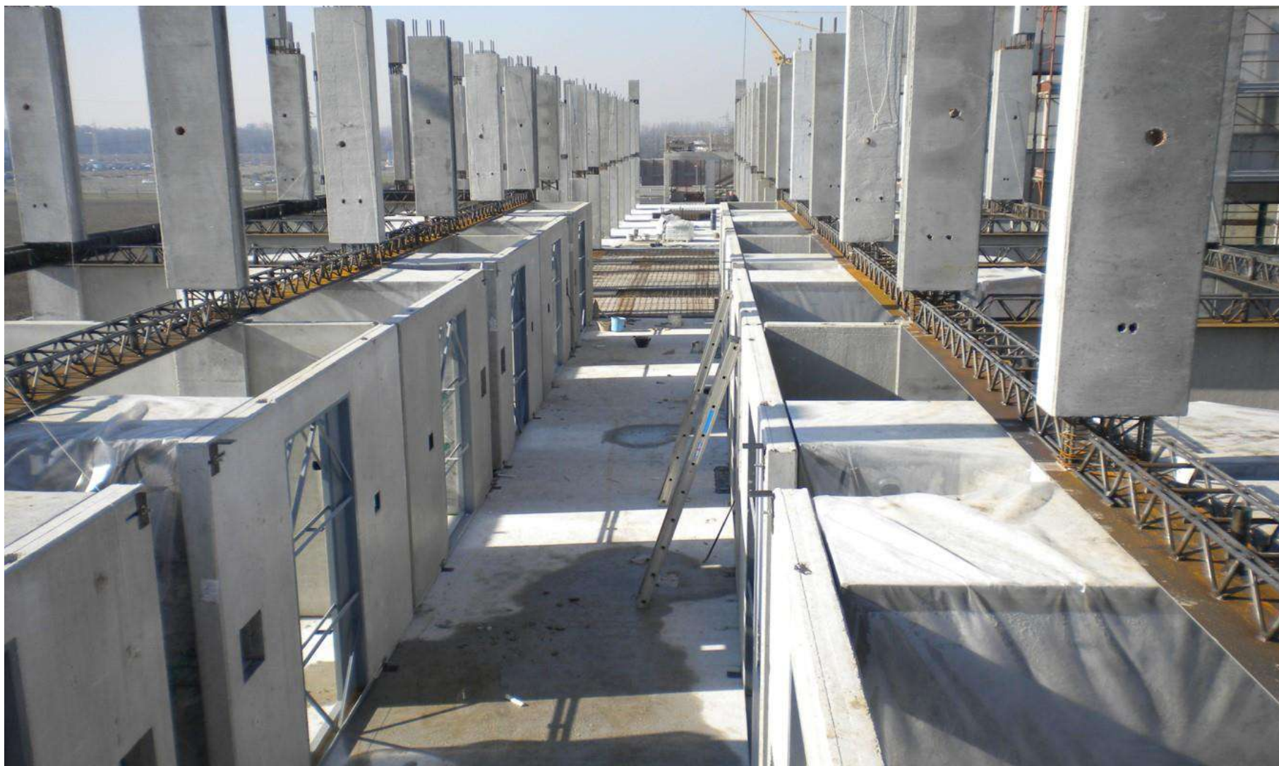
Nuovo Padiglione Carcerario (PV) – Travi PREM a1, Pilastri a N.U.S., Pannelli interni ed esterni e Cellule Bagno
