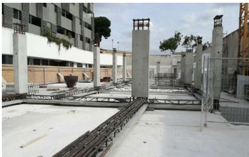
Condominio (Roma) – Pilastri a N.U.S. con Travi PREM b2+alveolare al primo piano e a1+solaio a tralici per gli altri
