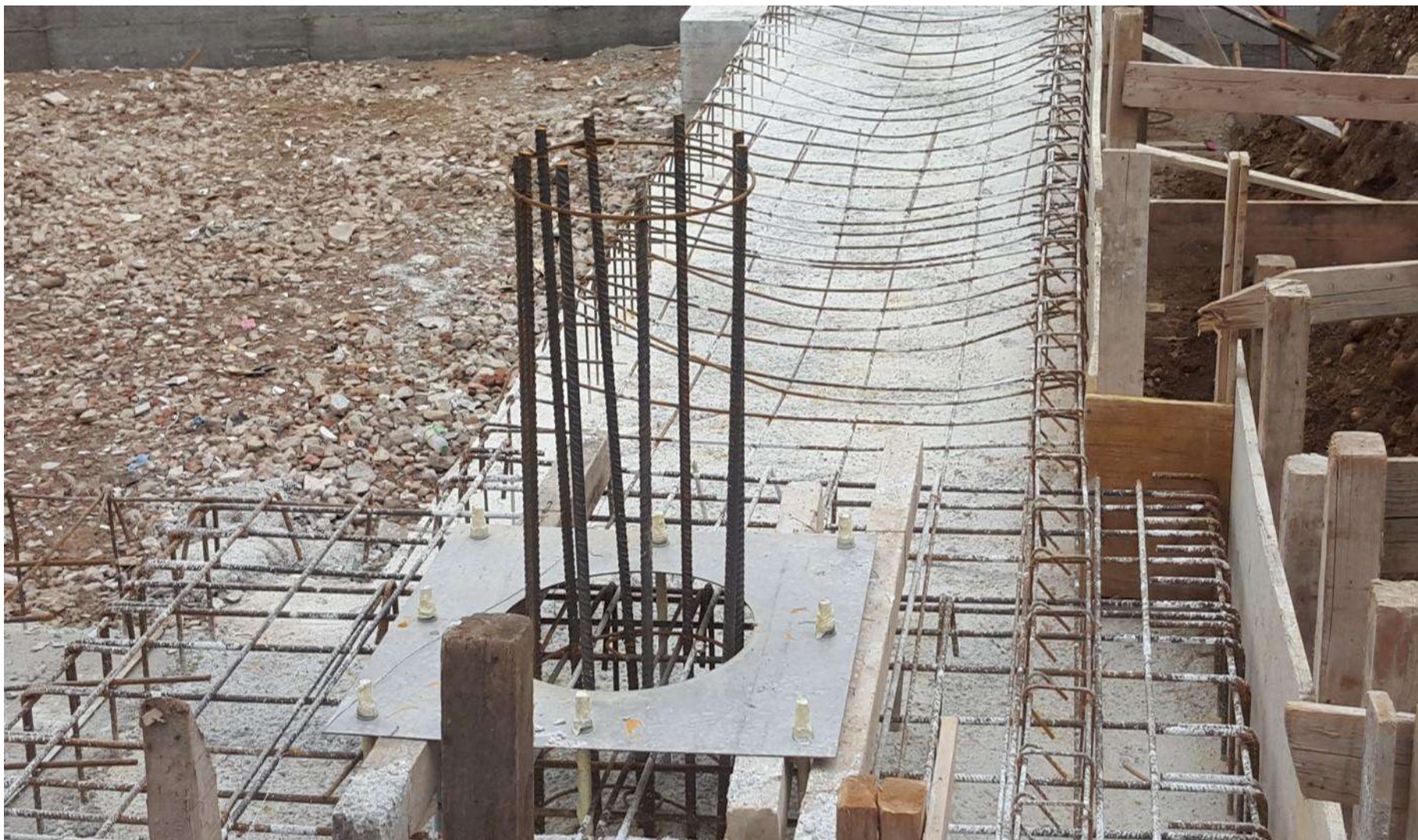
Tirafondi e ferri d'attesa per un Pilastro Cerchiato Misto.
