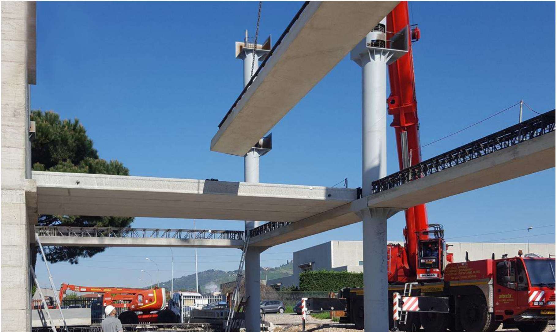
Sito Produttivo (LC) –Travi PREM b2 (con spondine in lamierino) e Casseri Tubolari in acciaio con Pilastri in c.a.o.
