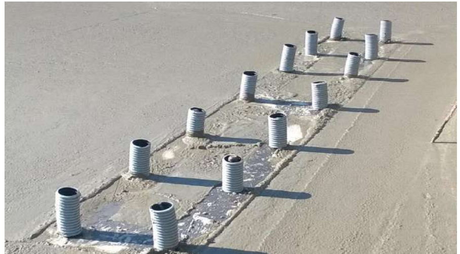
Tirafondi per un pilastro-setto protetti dal getto di cls
