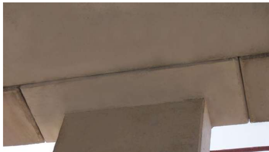
Uffici direzionali (VI): Travi PREM b2 – Solai a lastre nervate – Pilastri-Setti a Nodo Umido Strutturale
