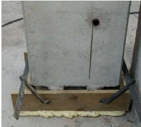
Posa e inghisaggio di un Pilastro Prefabbricato a N.U.S.
