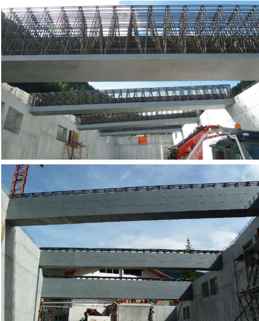
Nuovo parcheggio con copertura a gradoni (BZ) – Travi PREM a1 con casseri in lamierino a perdere
