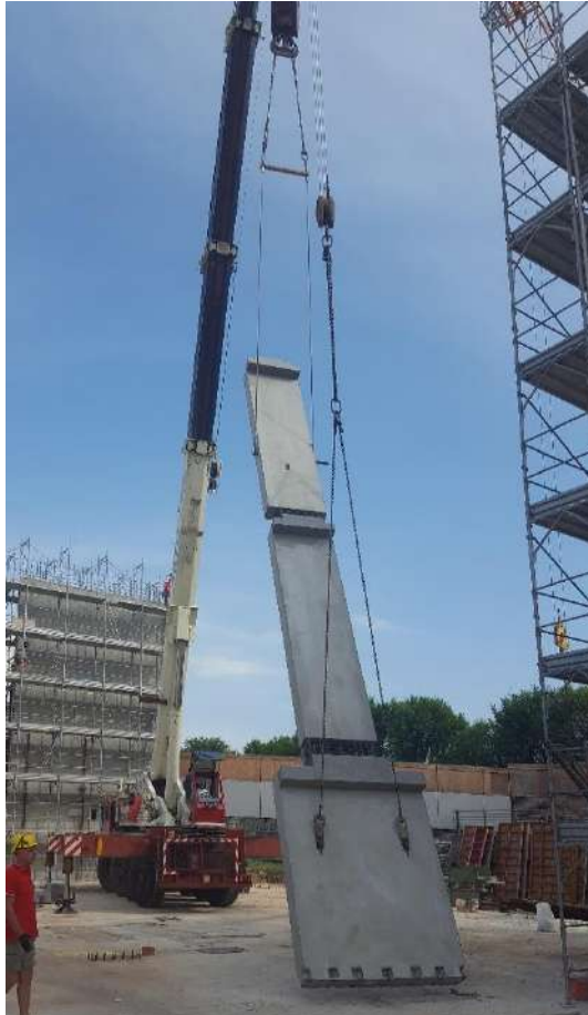
Pilastro Prefabbricato a Nodo Umido Strutturale
