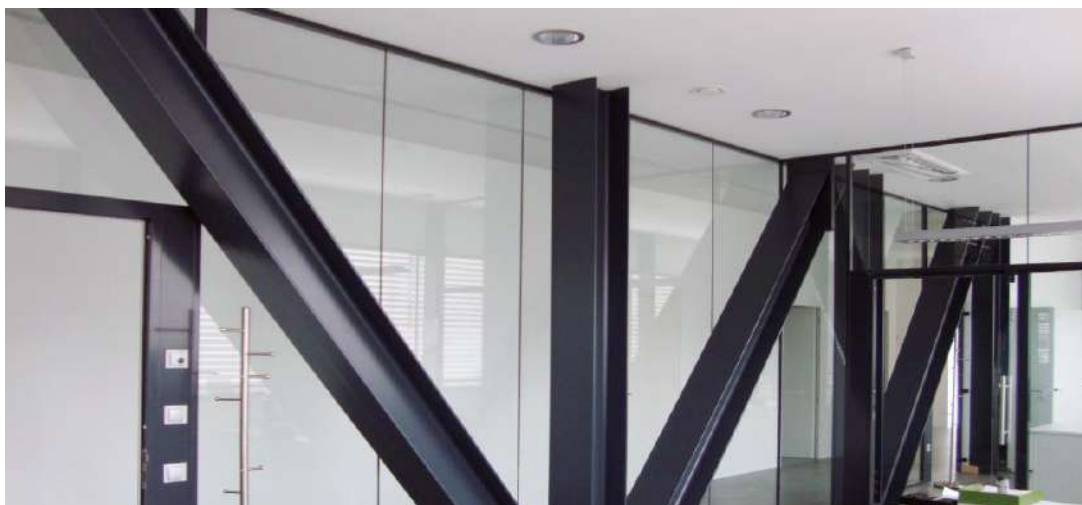
Uffici direzionali (BZ) – Travi PREM a1 con tiranti e puntoni per una reticolare ad altezza di interpiano
