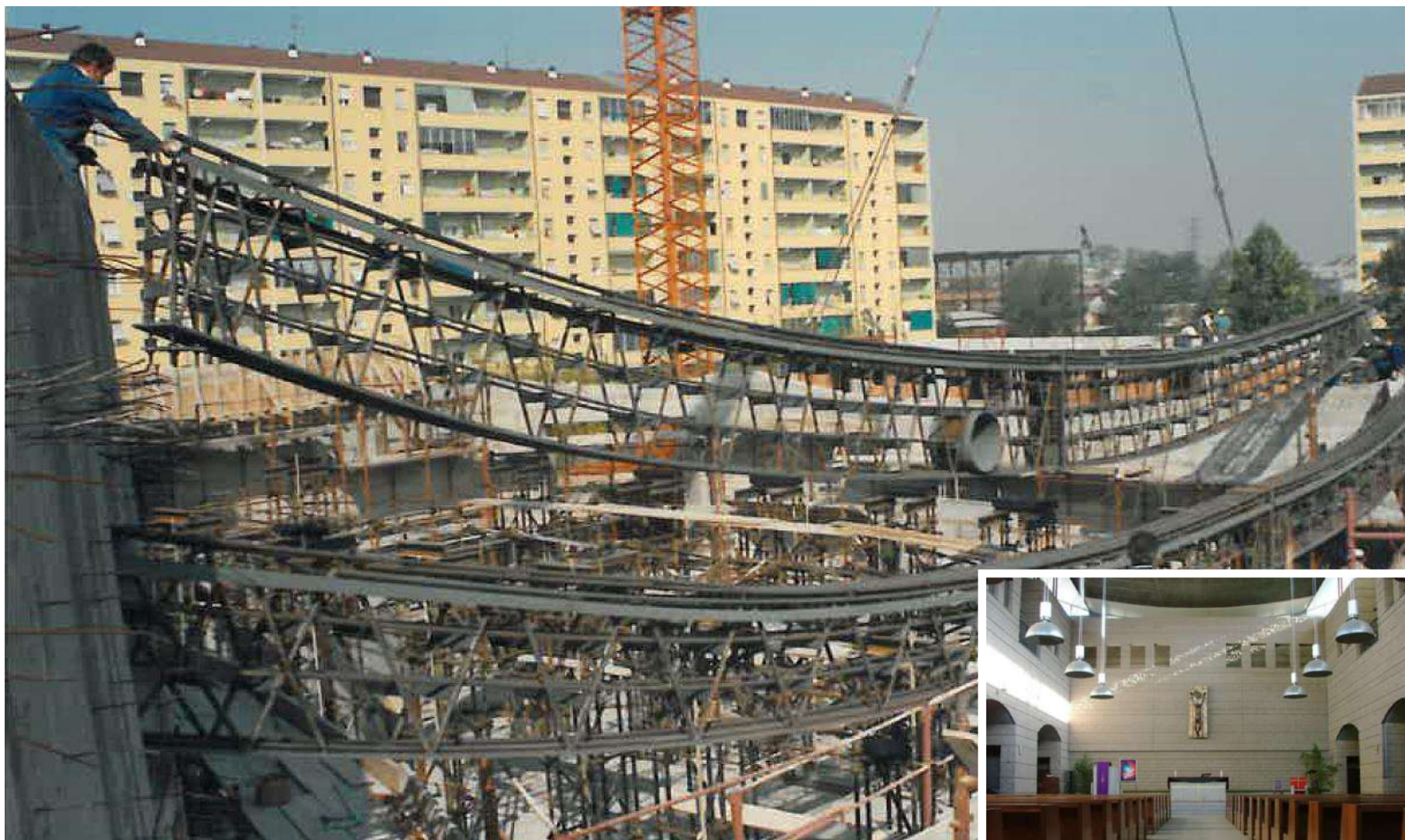
Nuova Chiesa (MI) – Travi PREM a1 della copertura concava
