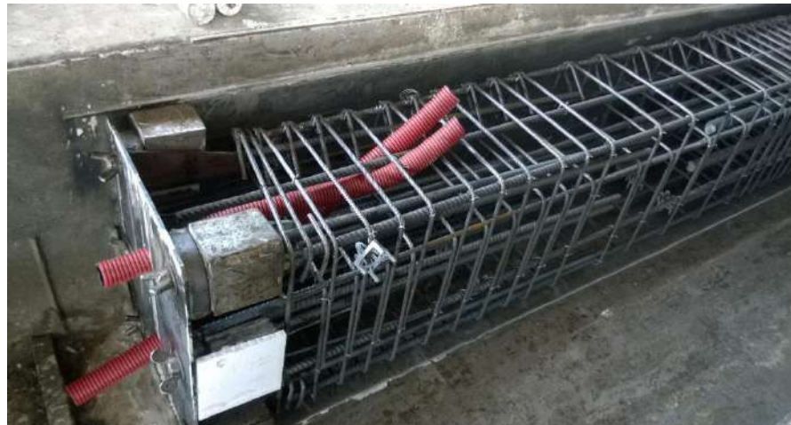
Predisposizione di Base con tubi per getto inghisaggio
