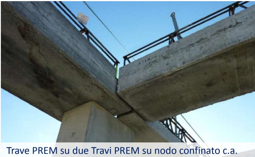
Travi PREM con fondello cls su pilastro c.a. gettato i.o.
