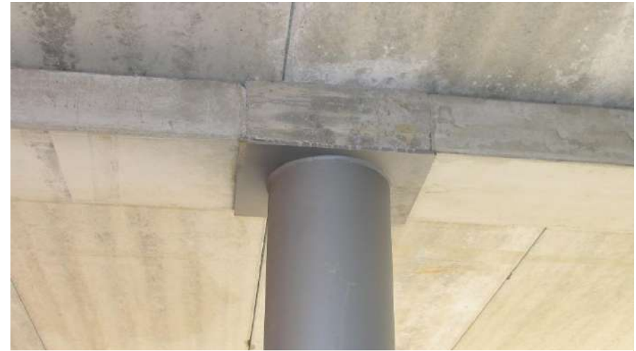
Nodo al finito fra Travi PREM con fond. cls e Pil.Cerc.M.
